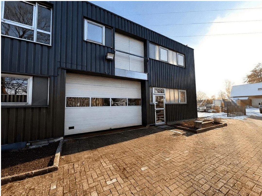
Außenansicht Rolltor / Tor
