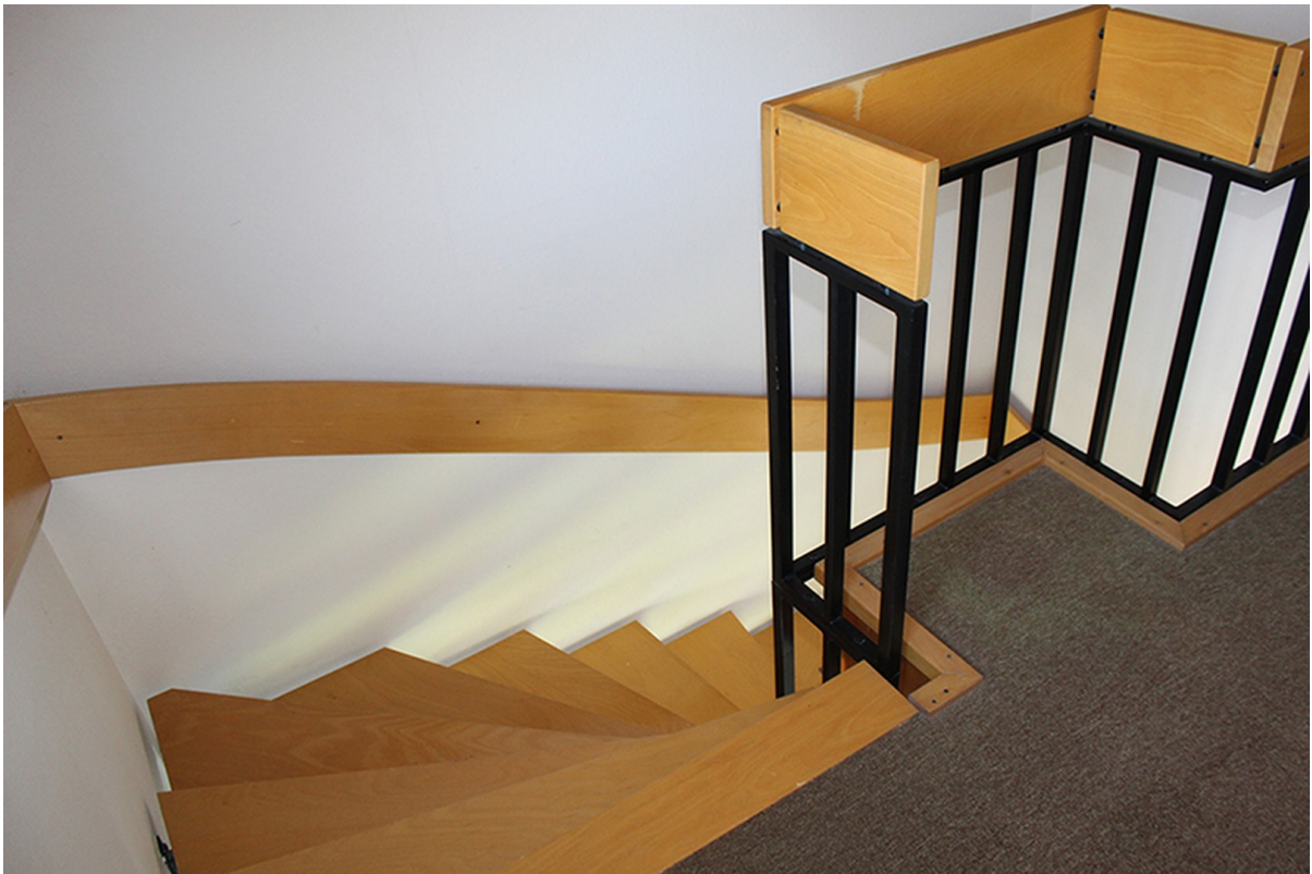
Stahl-Holztreppe von OG ins EG
