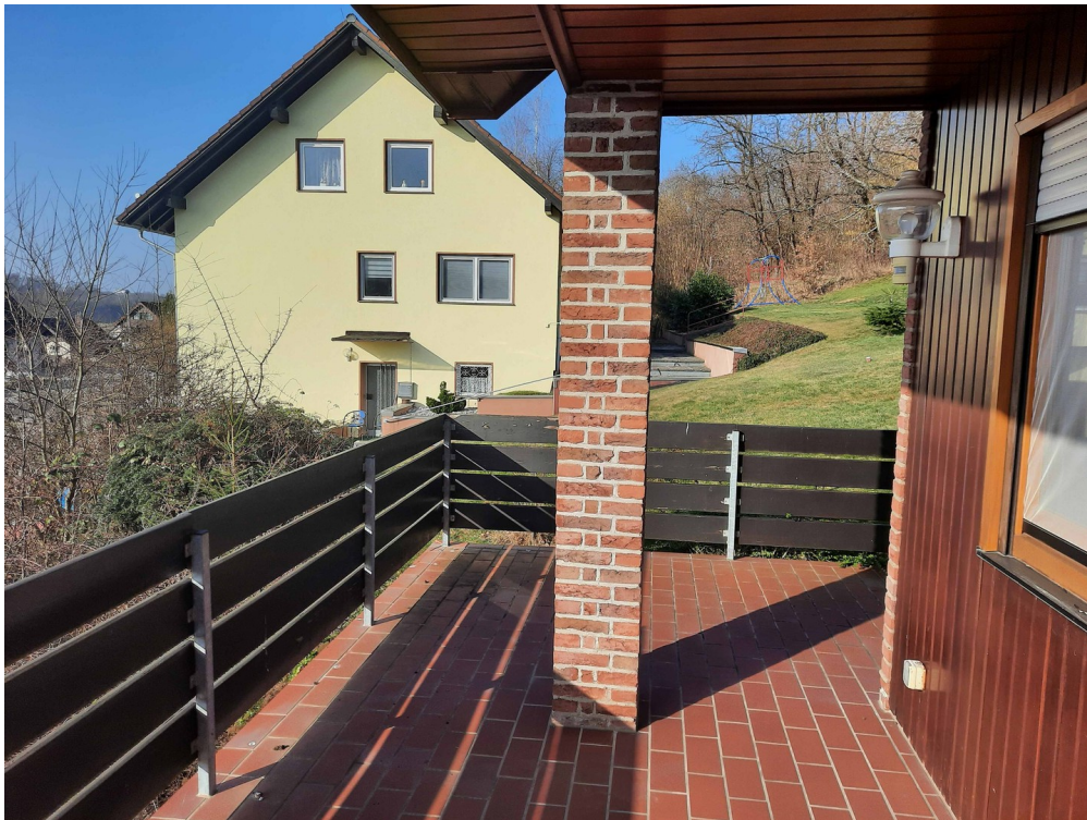
EG Balkon beim Wohnzimmer
