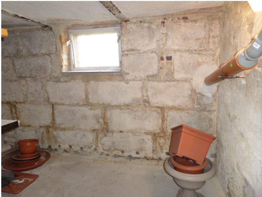
Kellerraum Beispiel KG
