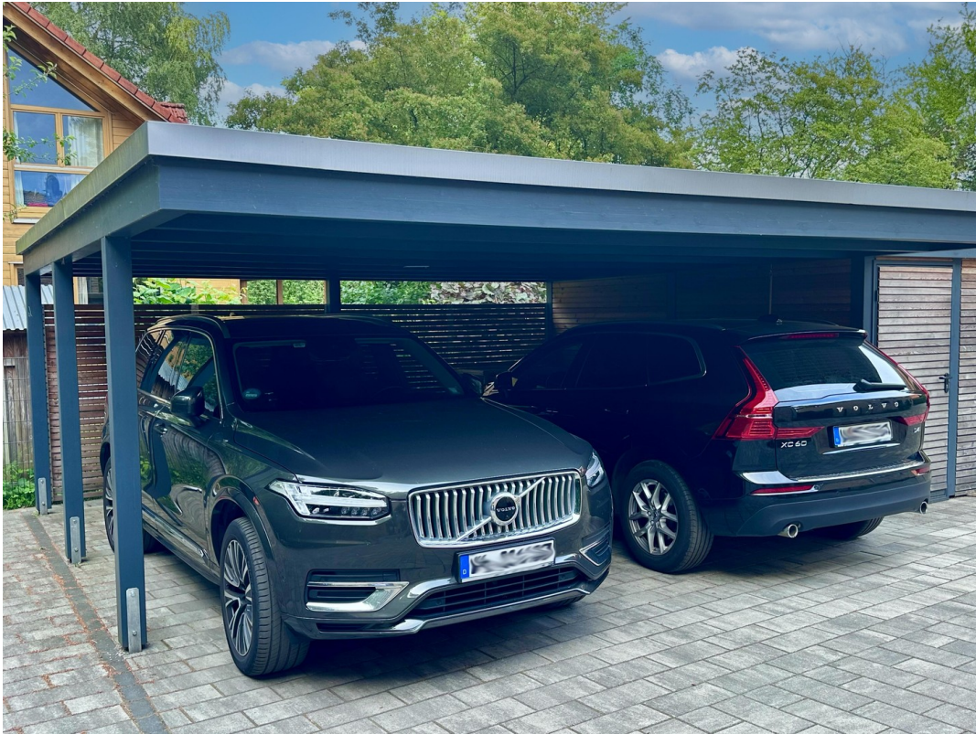
Doppelcarport mit Abstellraum
