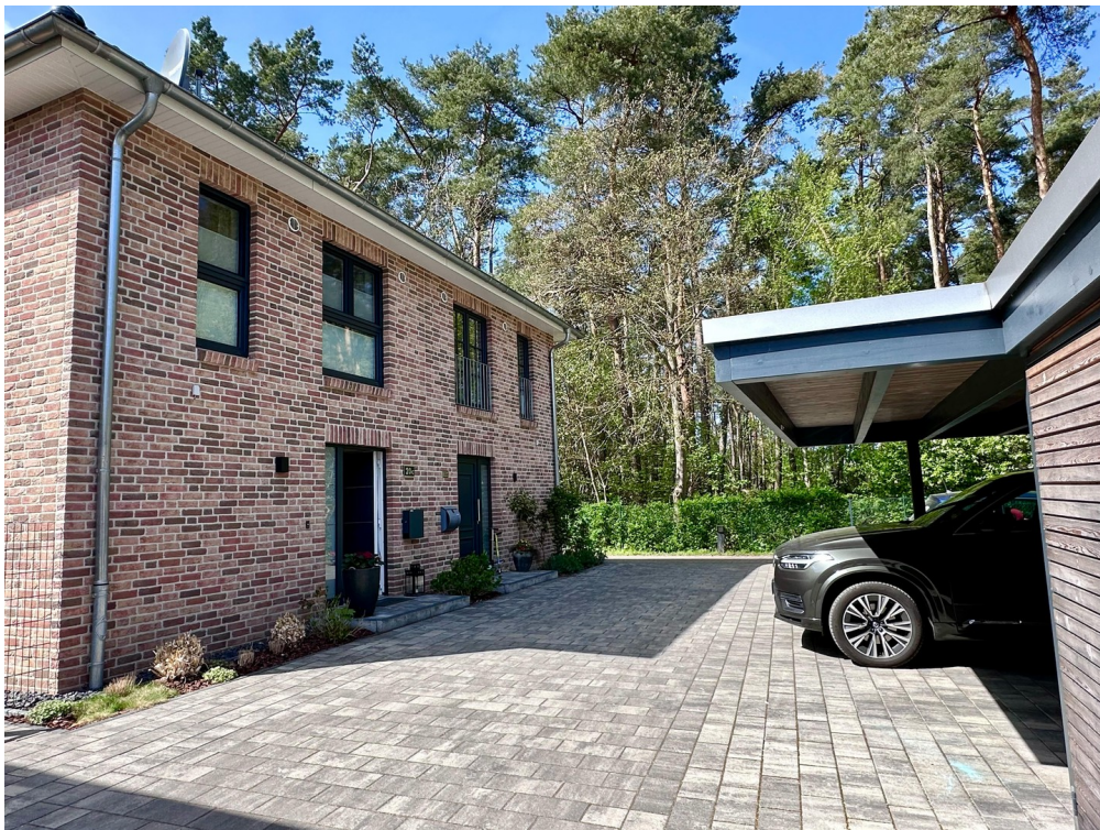
Einfahrt mit Carport
