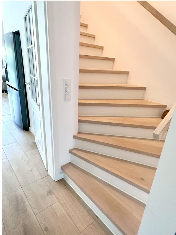
Treppe mit Echtholzbelag
