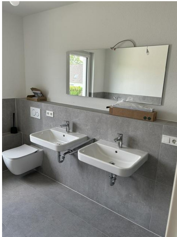
Badezimmer im OG
