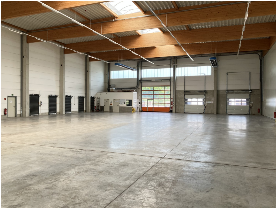
Lagerhalle Blick Lagereingang
