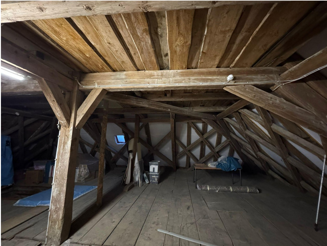
Dachstuhl als Stauraum
