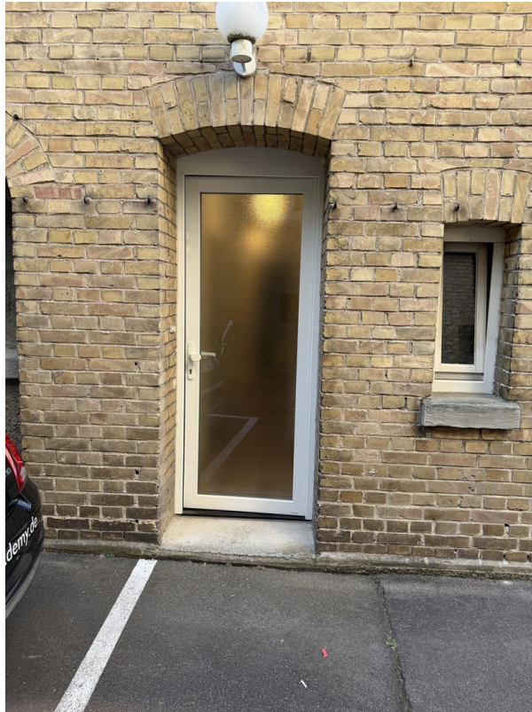
Eingang Wohnung Außen
