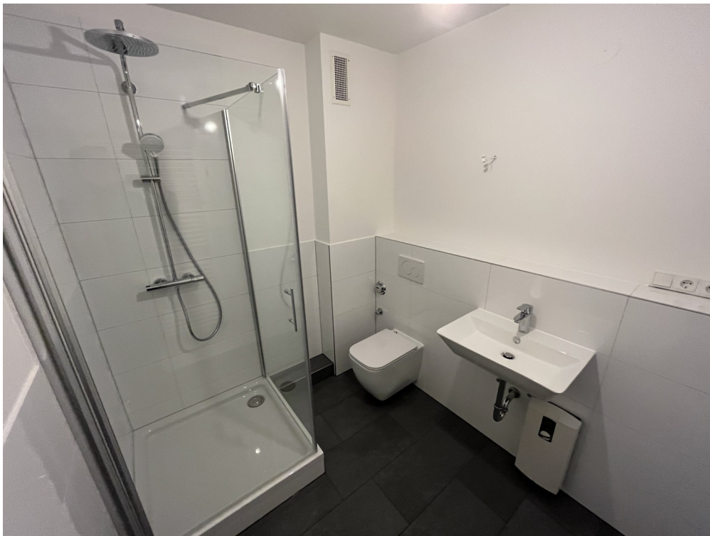
Bad mit Dusche und WC
