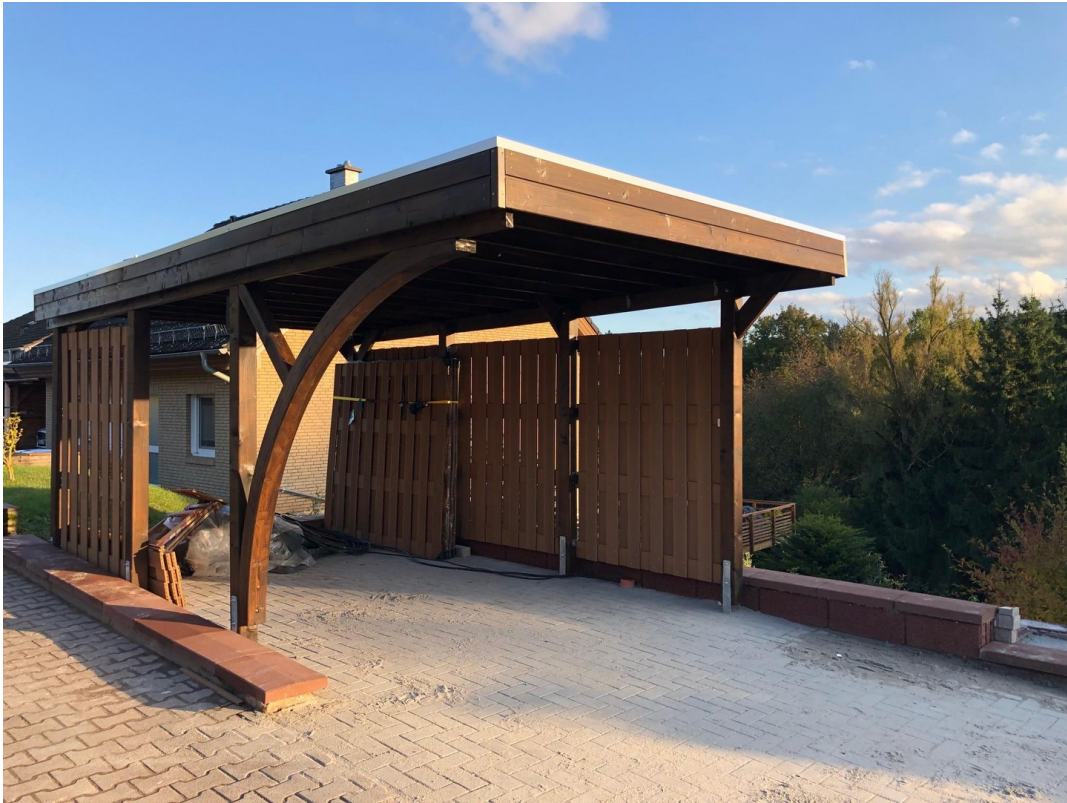
Carport mit Wall-Box
