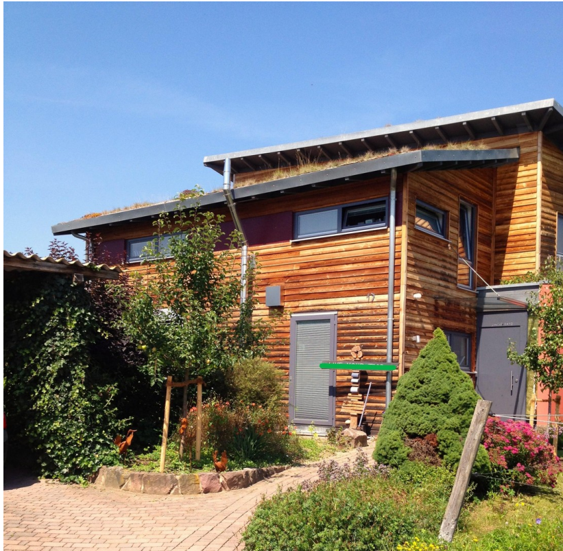
Ansicht Eingang u. Küchentür
