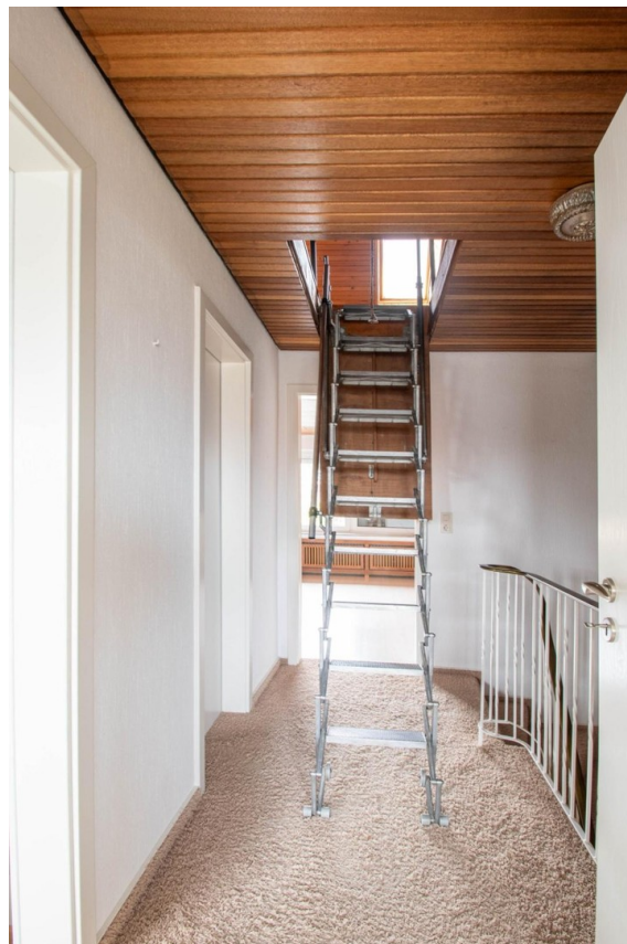
Zugang zum Dachgeschoß
