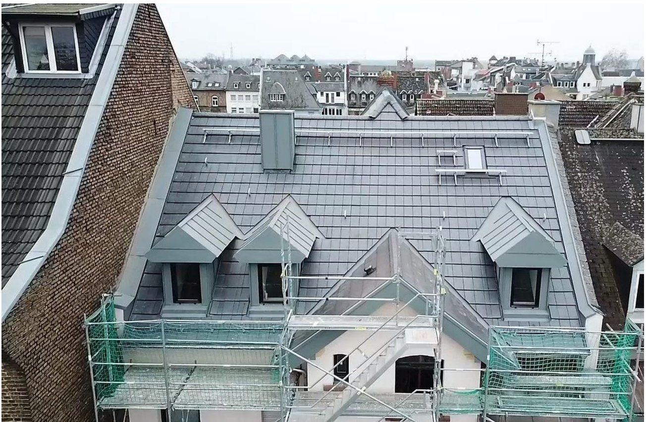
Bild Dach neu Innseite Hof
