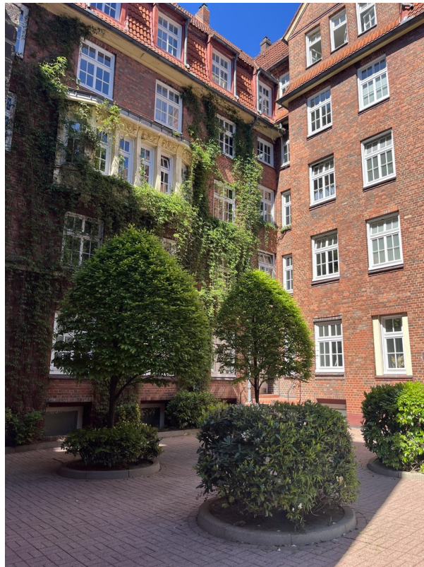
Blick von der Straße
