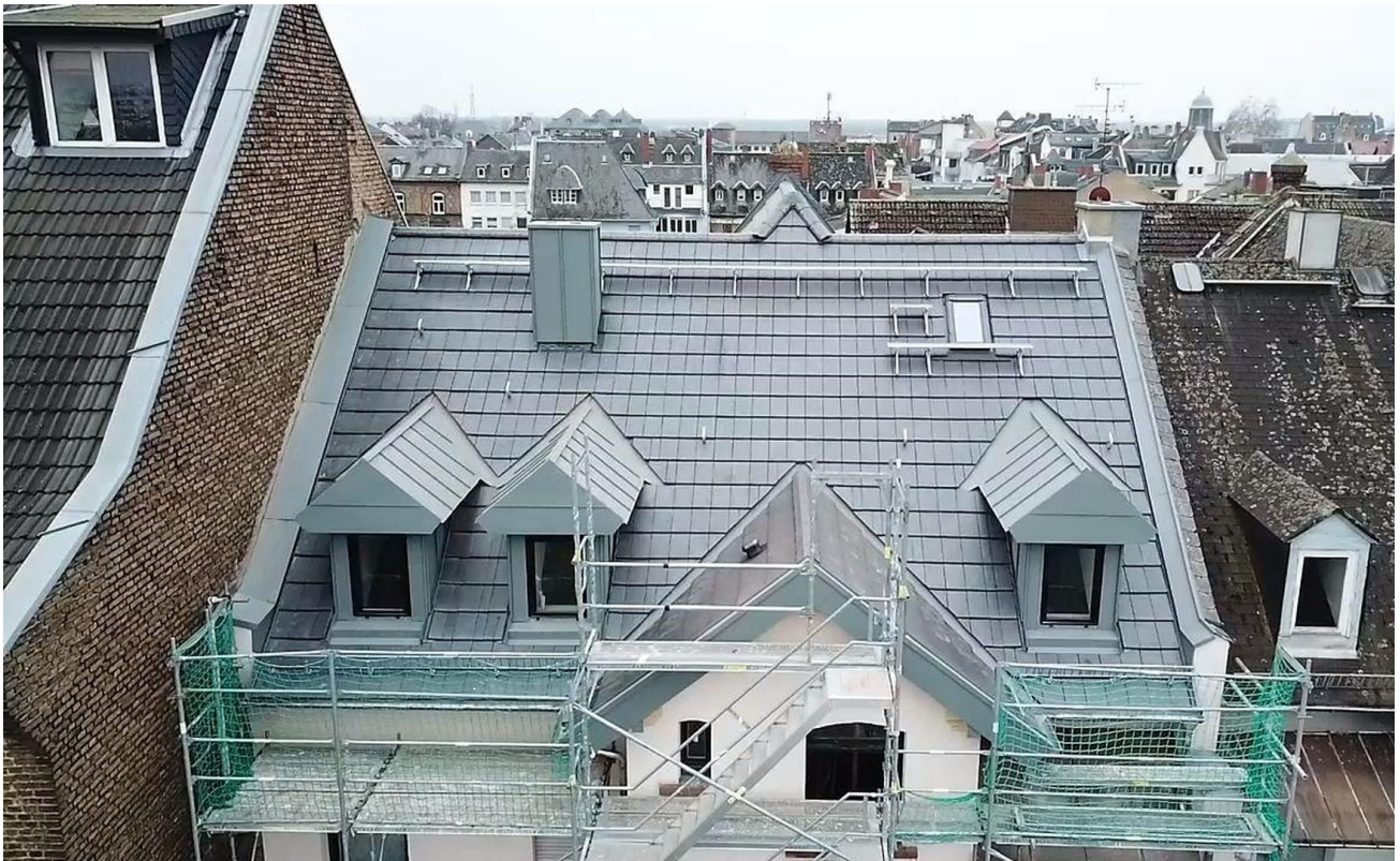
Dach neu, Teil Hofseite
