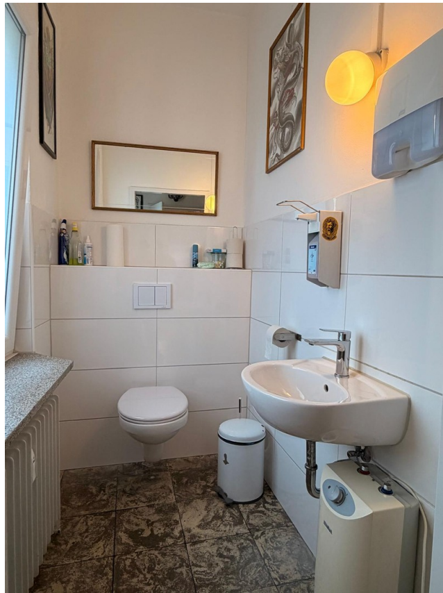
Wc / sanitäre Anlagen
