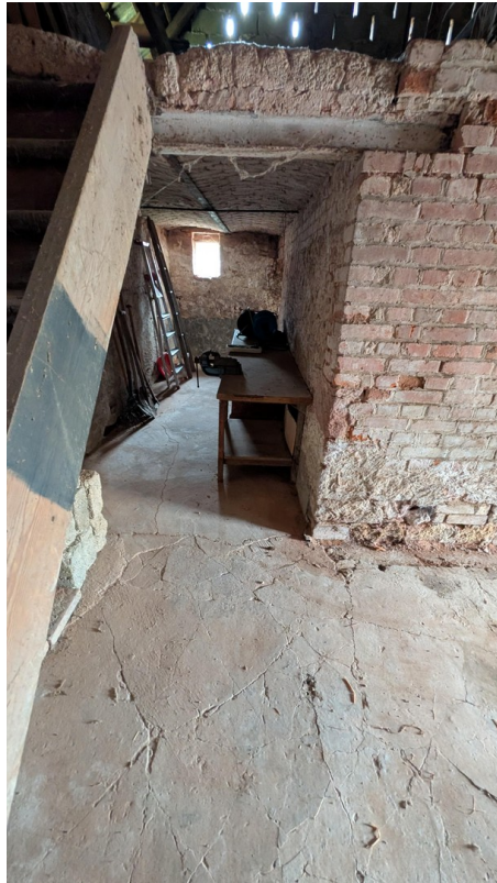
Scheune EG Durchgang Stall
