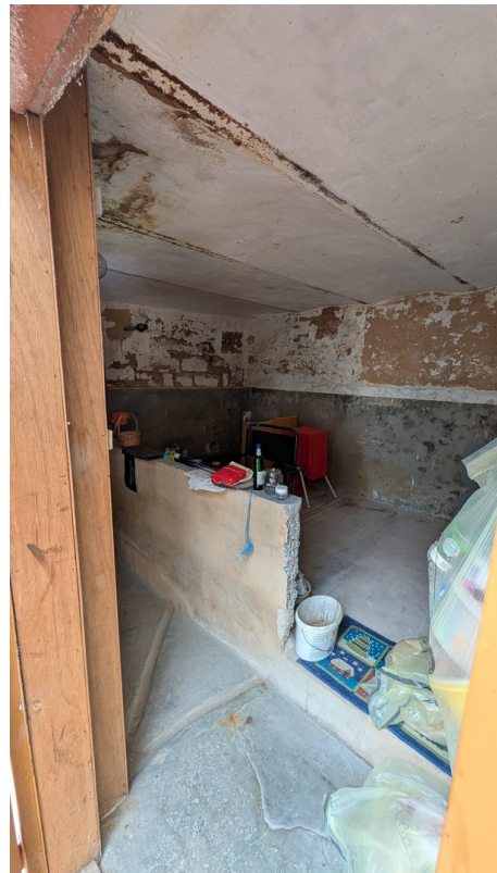
Seitenanbau Stauraum ex Ölraum
