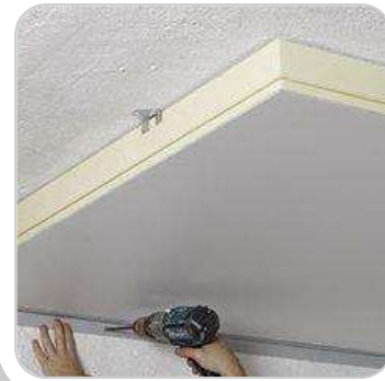
Verarbeitungsbeispiel Wärmedämmung
