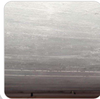
undämmte Kellderdecke
