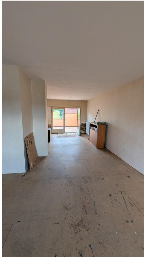
OG Wohnzimmer zu Dachterrasse
