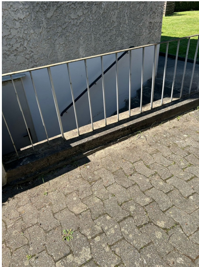
Kellerzugang von außen
