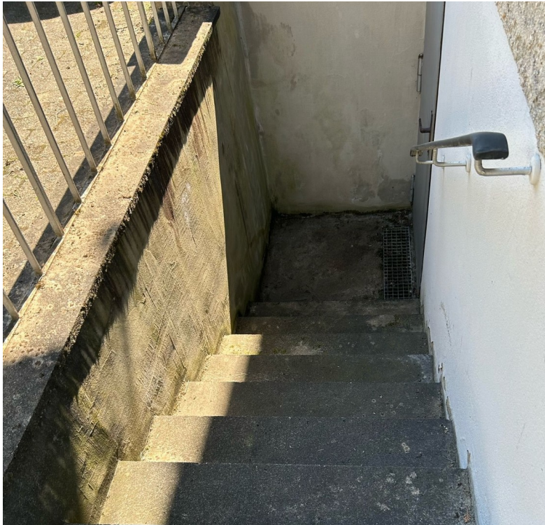
Kellertreppe von außen
