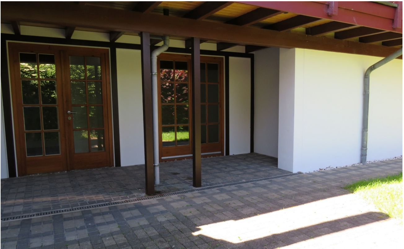
Eigener Eingang / Terrasse
