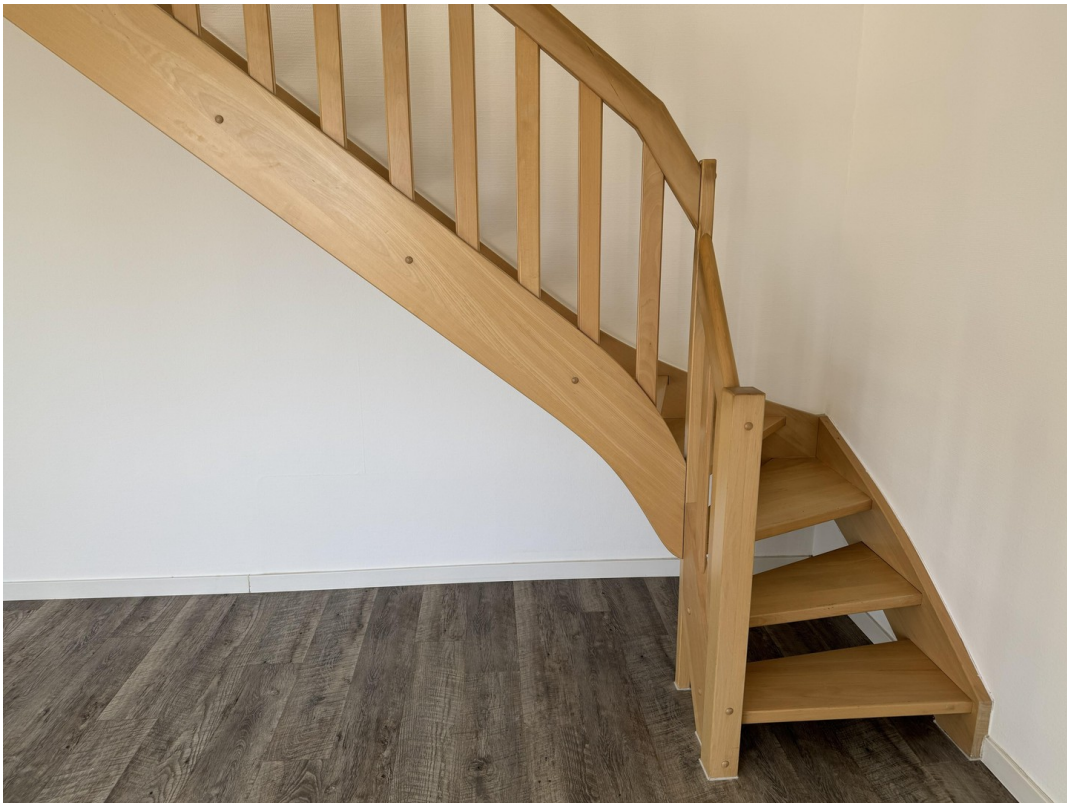
Treppe zum Obergeschoss
