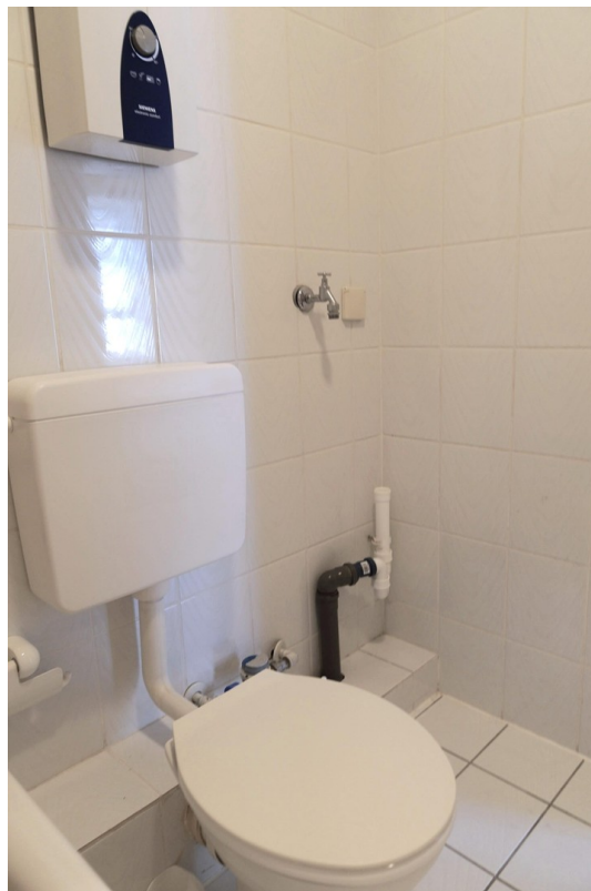
Waschmaschinenanschluss Bad
