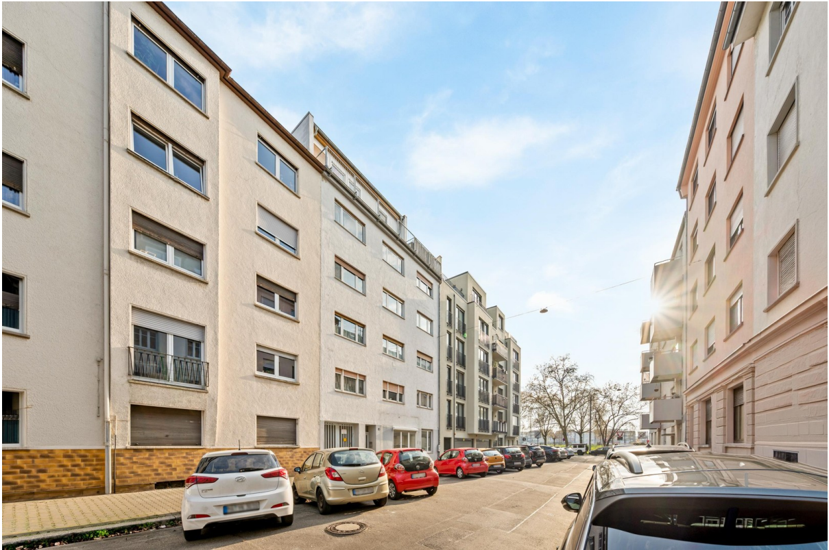
Gebäude vom außen
