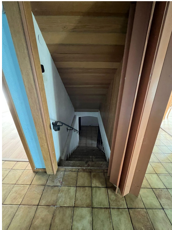
Treppe zum Keller
