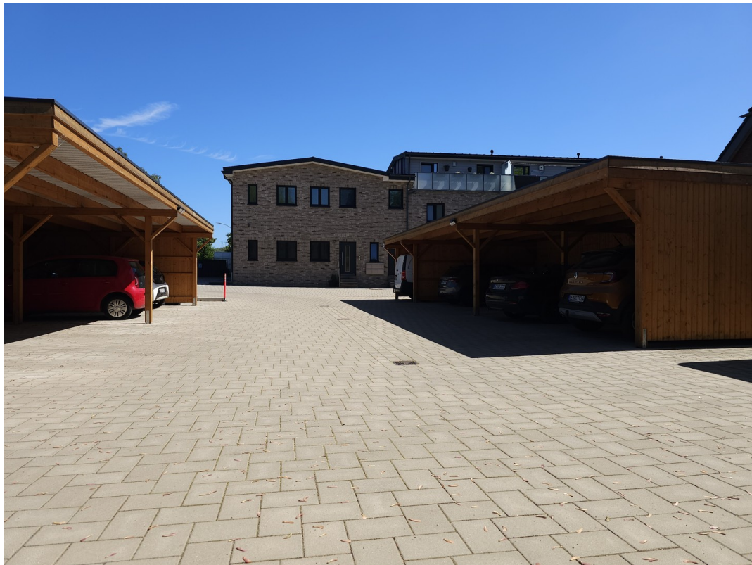
Carportanlage mit 1.Stellplatz
