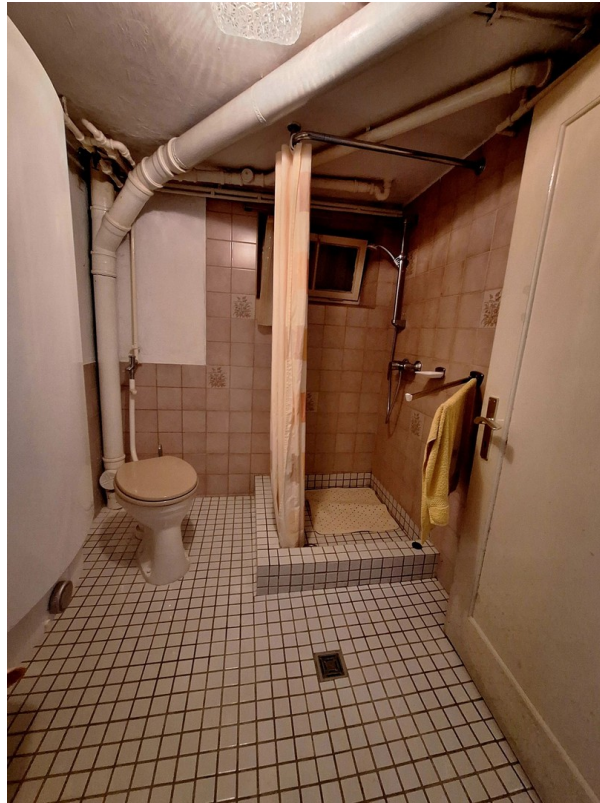
Dusche/WC im Keller
