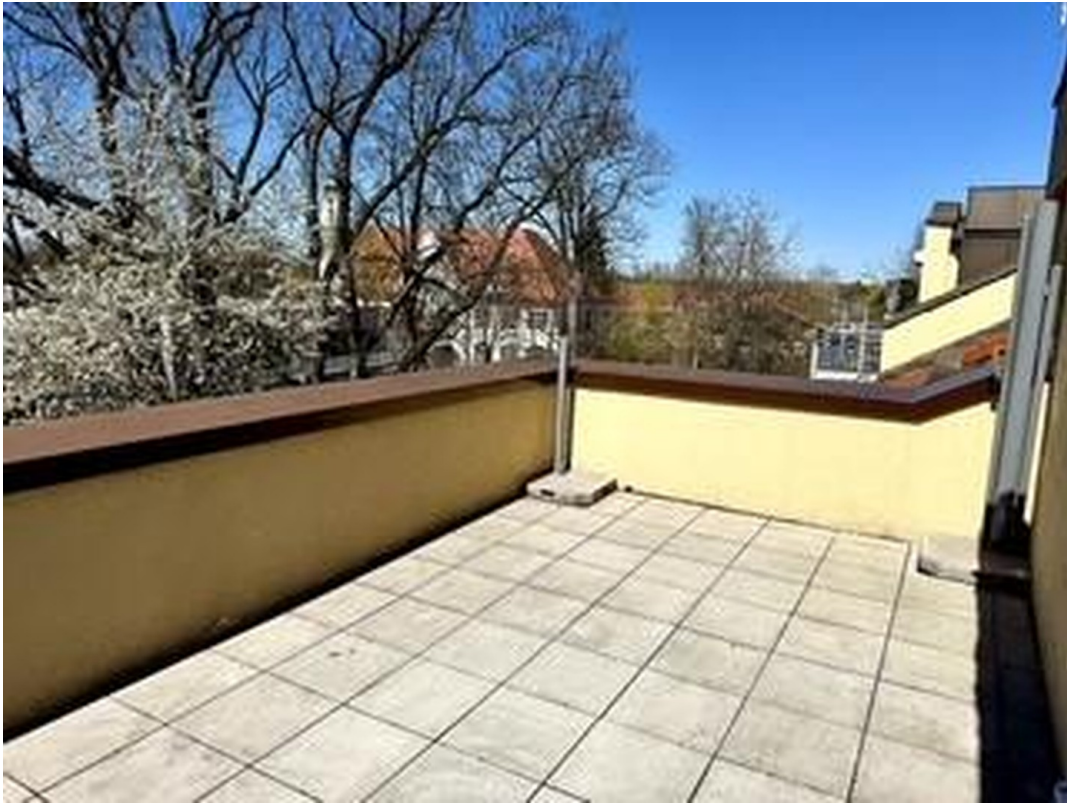
Dachterrasse Blick nach Norden
