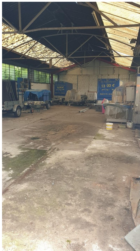
Halle ( von Innen, 21 x 10 m )
