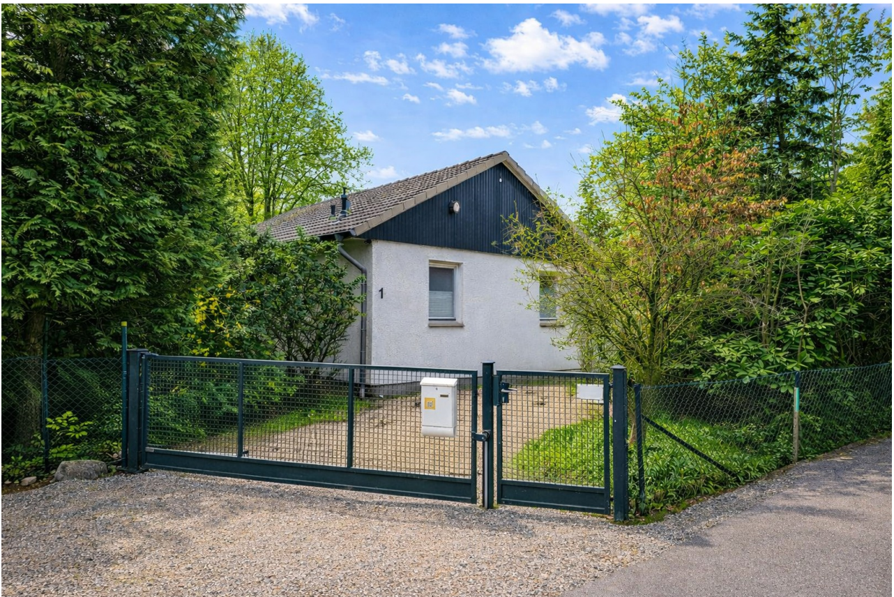
Straßenansicht mit elektr. Tor
