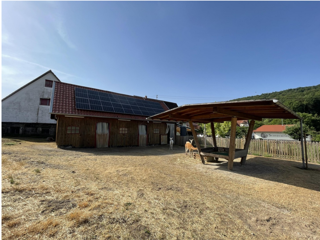
Offenstall, Heuraufe Überdacht
