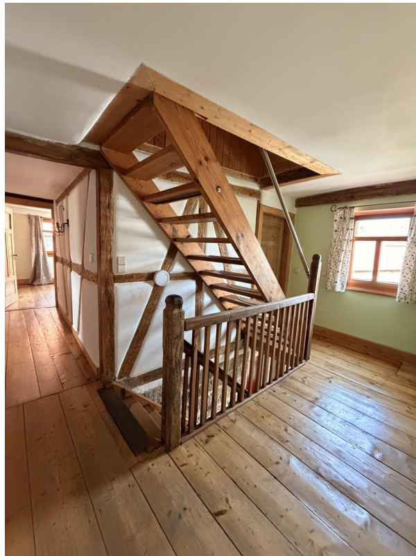
Treppenhaus im Bauernhaus
