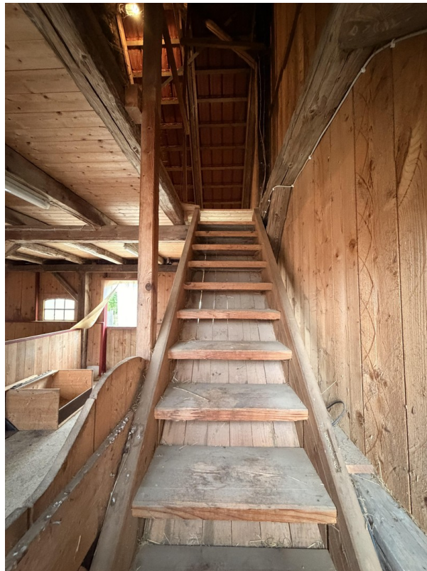
Pferdestall Treppe Heulager
