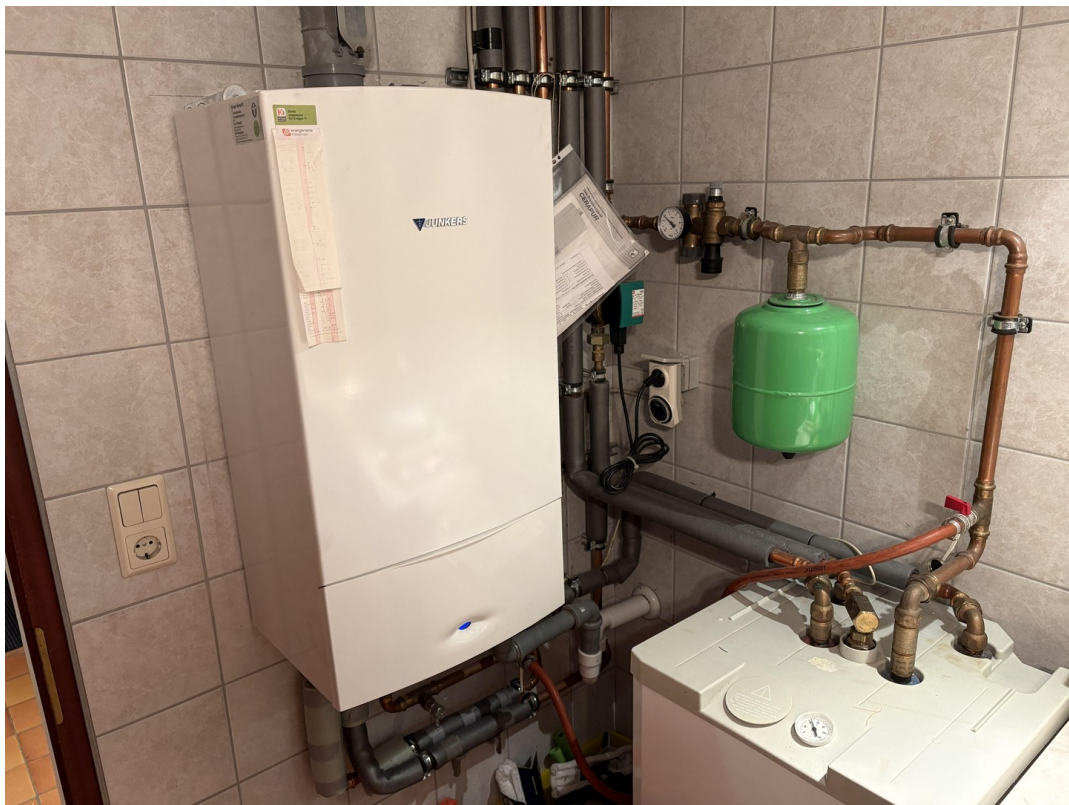
Gastherme mit Warmwasser
