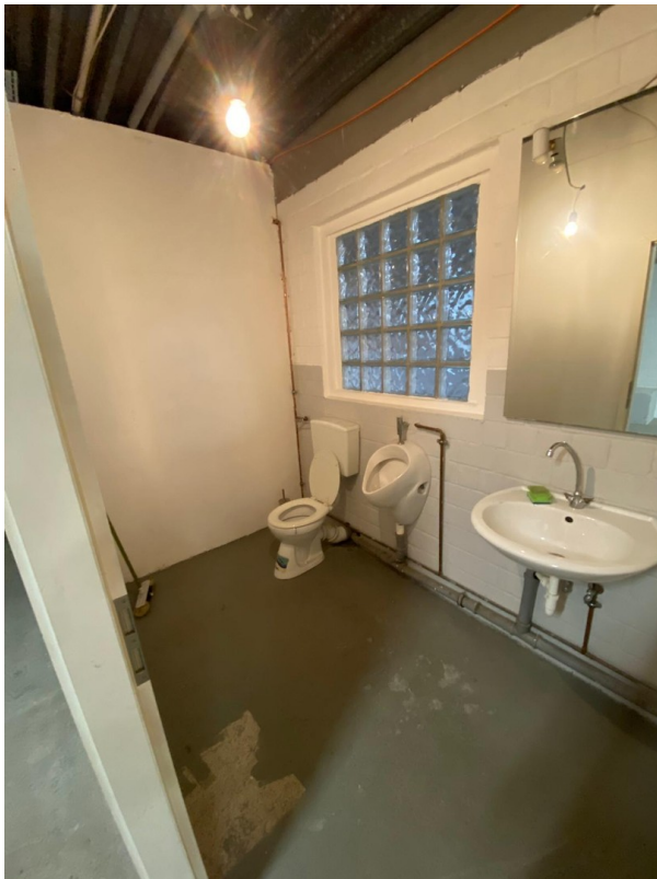
Halle - WC Bereich
