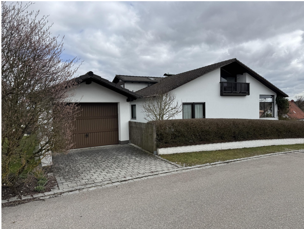
Westfassade mit Balkon/ Garage
