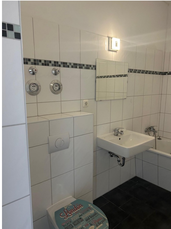
Duschtrennwand inzw. eingebaut
