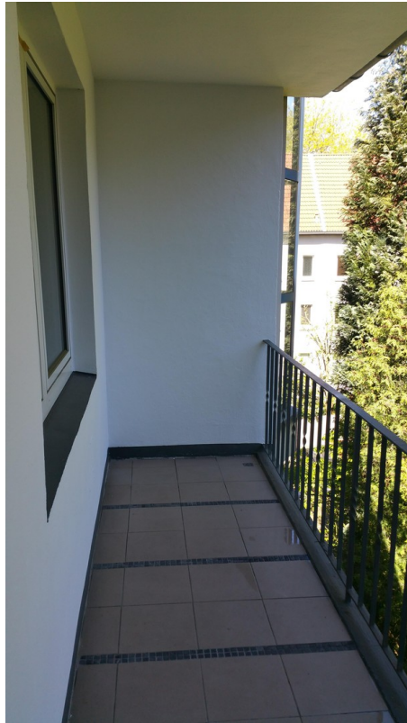
Balkon Hausrückseite Garten
