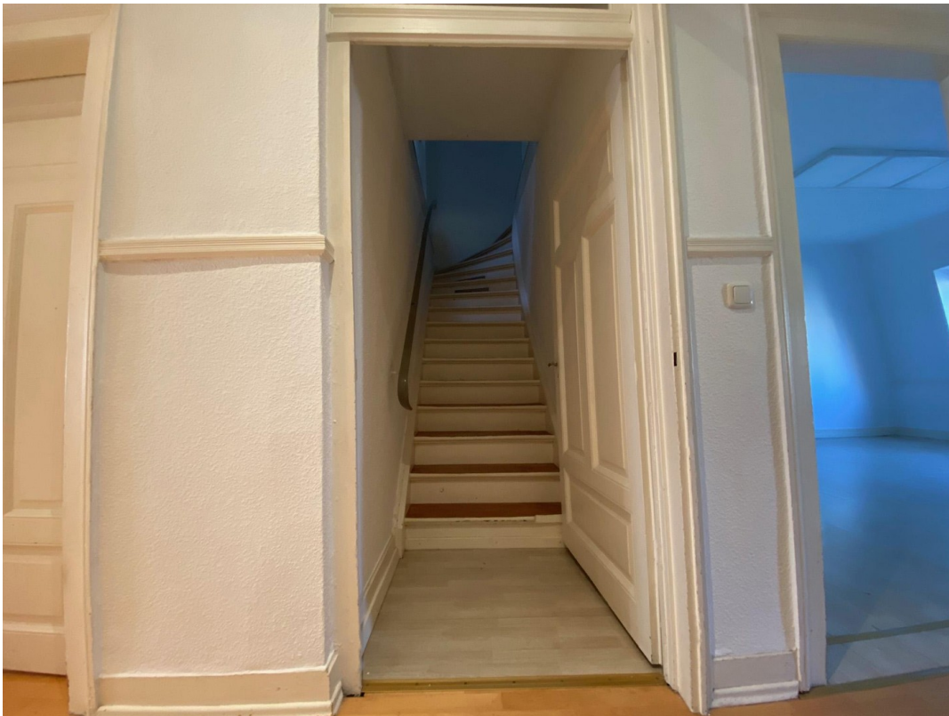
Treppenaufgang zum Speicher
