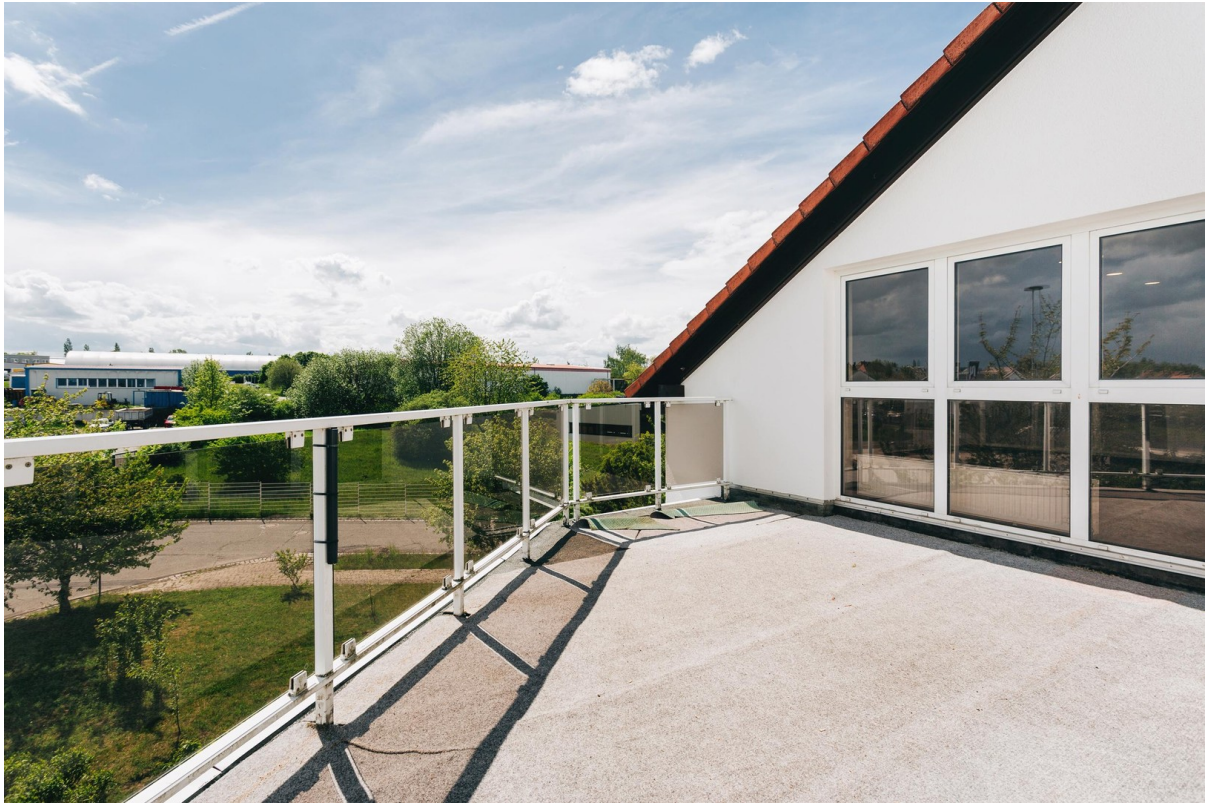
Dachterasse - Ist Zustand
