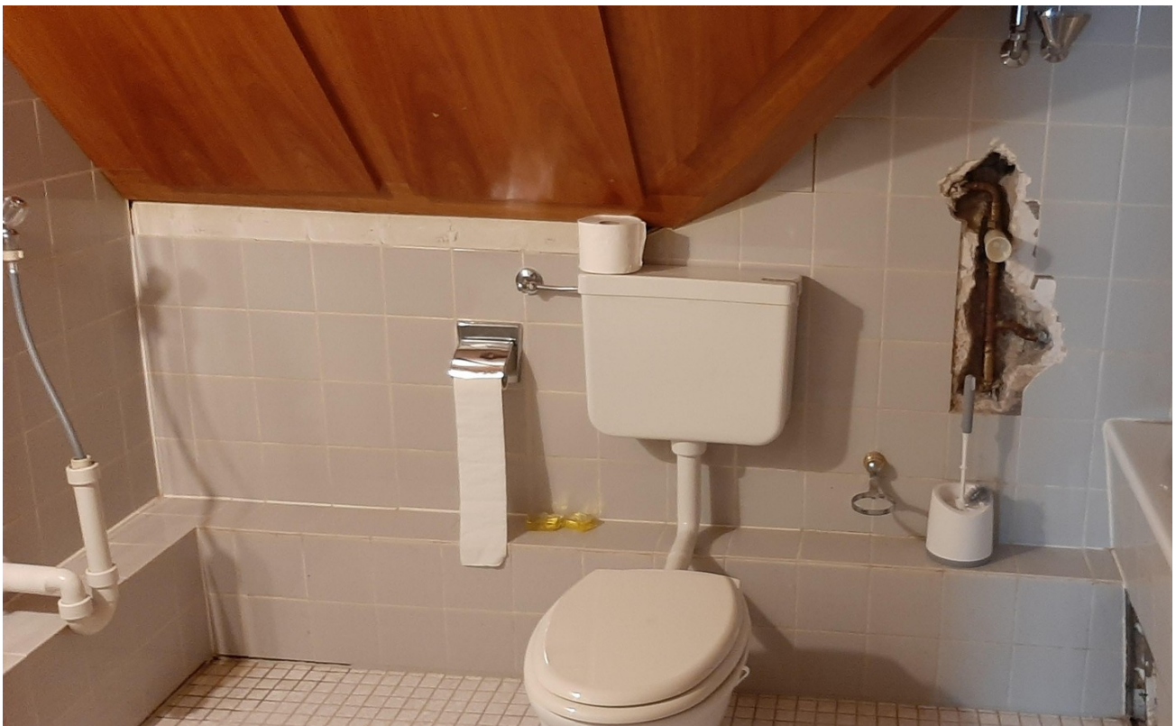
Bad, Wasserabsperung erneuert
