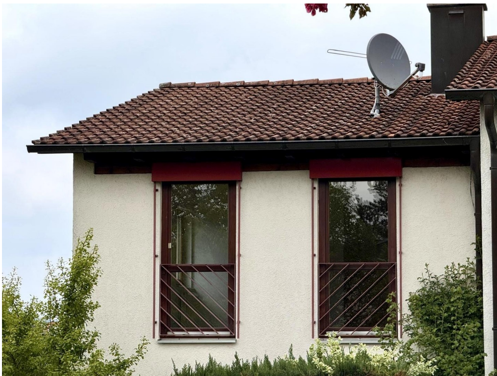
Ansicht SW (DG)
