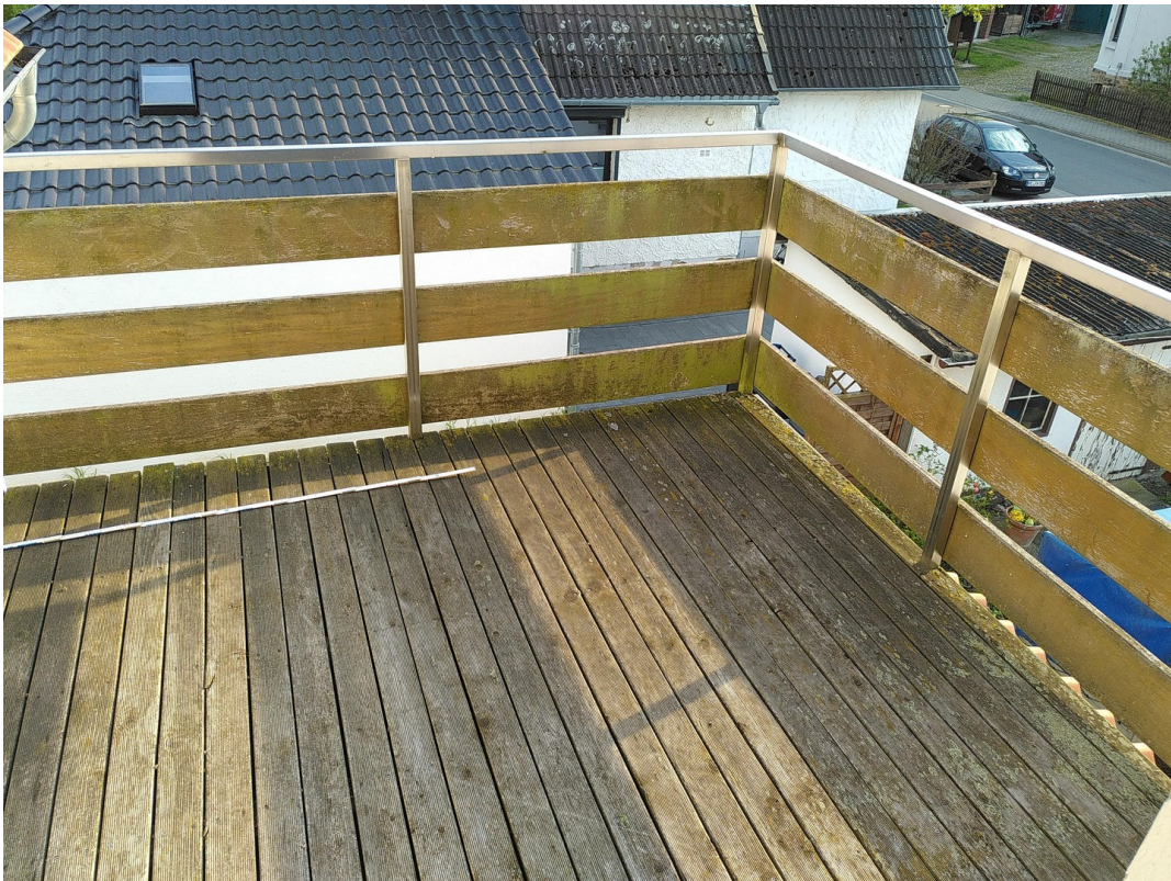
Dachterrasse OG vorn
