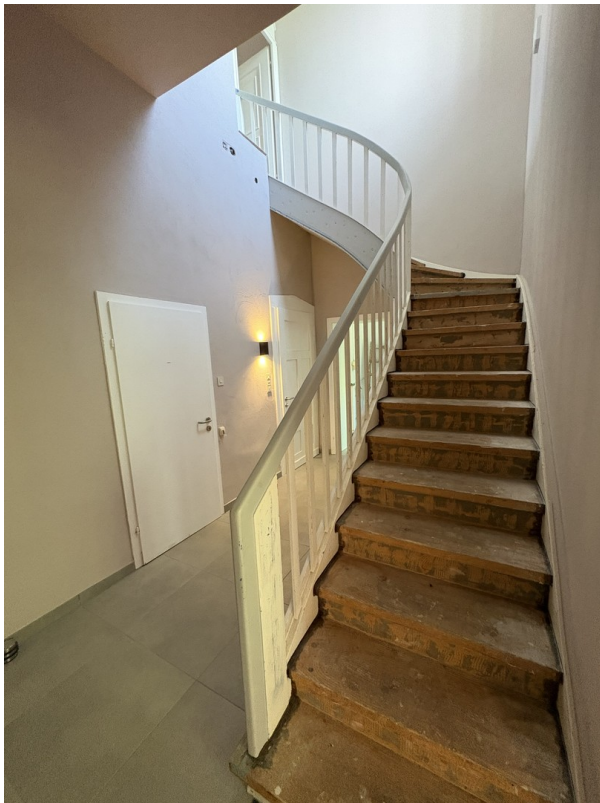
Treppenhaus in obere Wohnung
