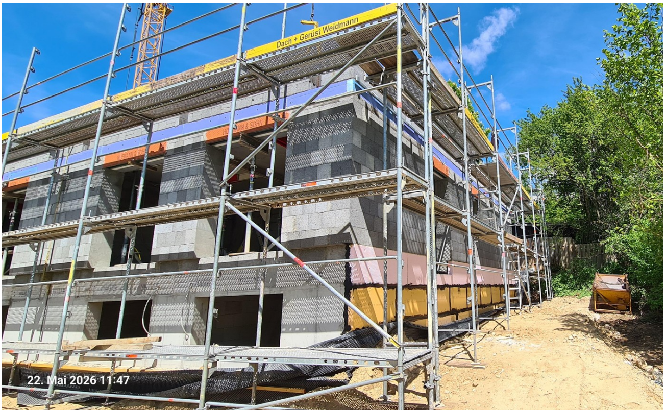
Bautenstand Süd-Ost Ansicht
