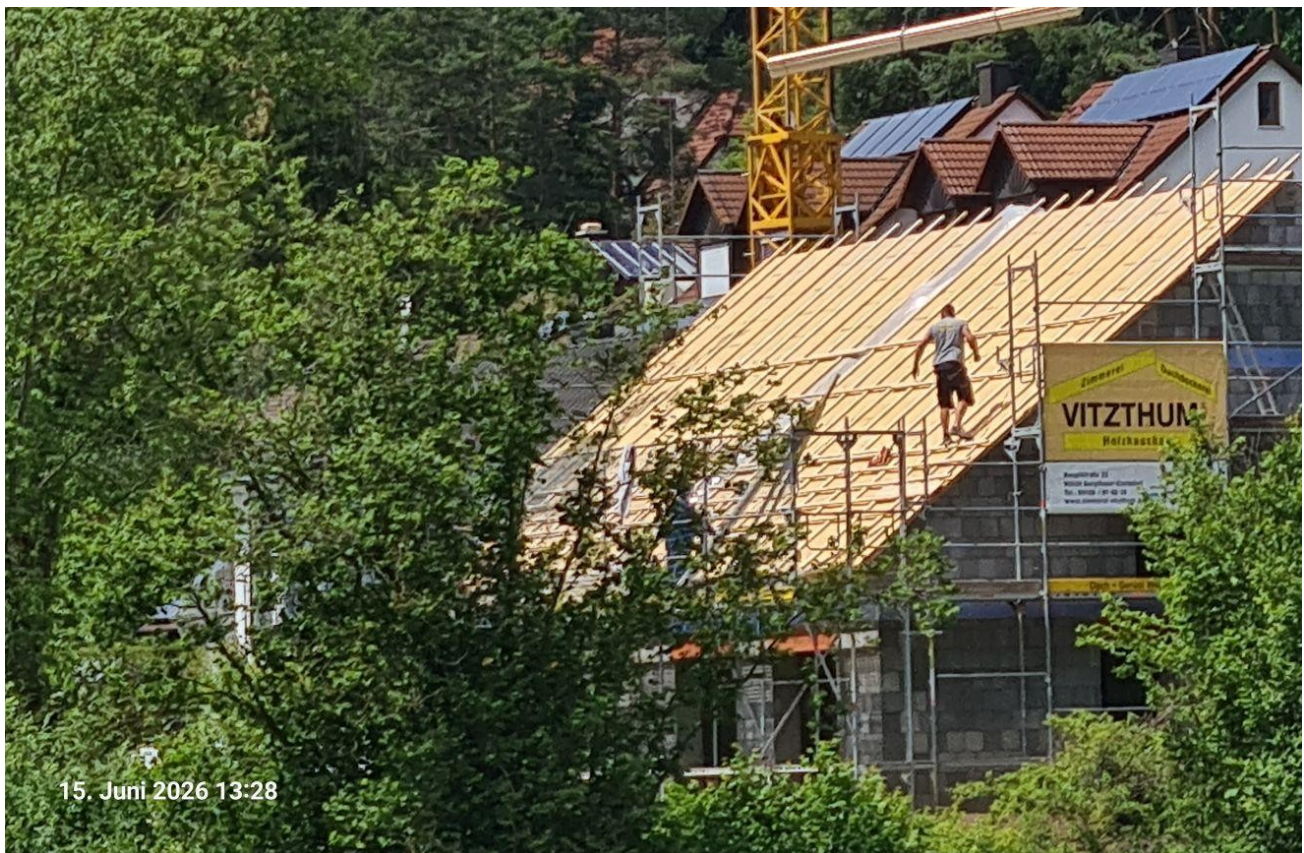
Bautenstand Süd-Ost Ansicht
