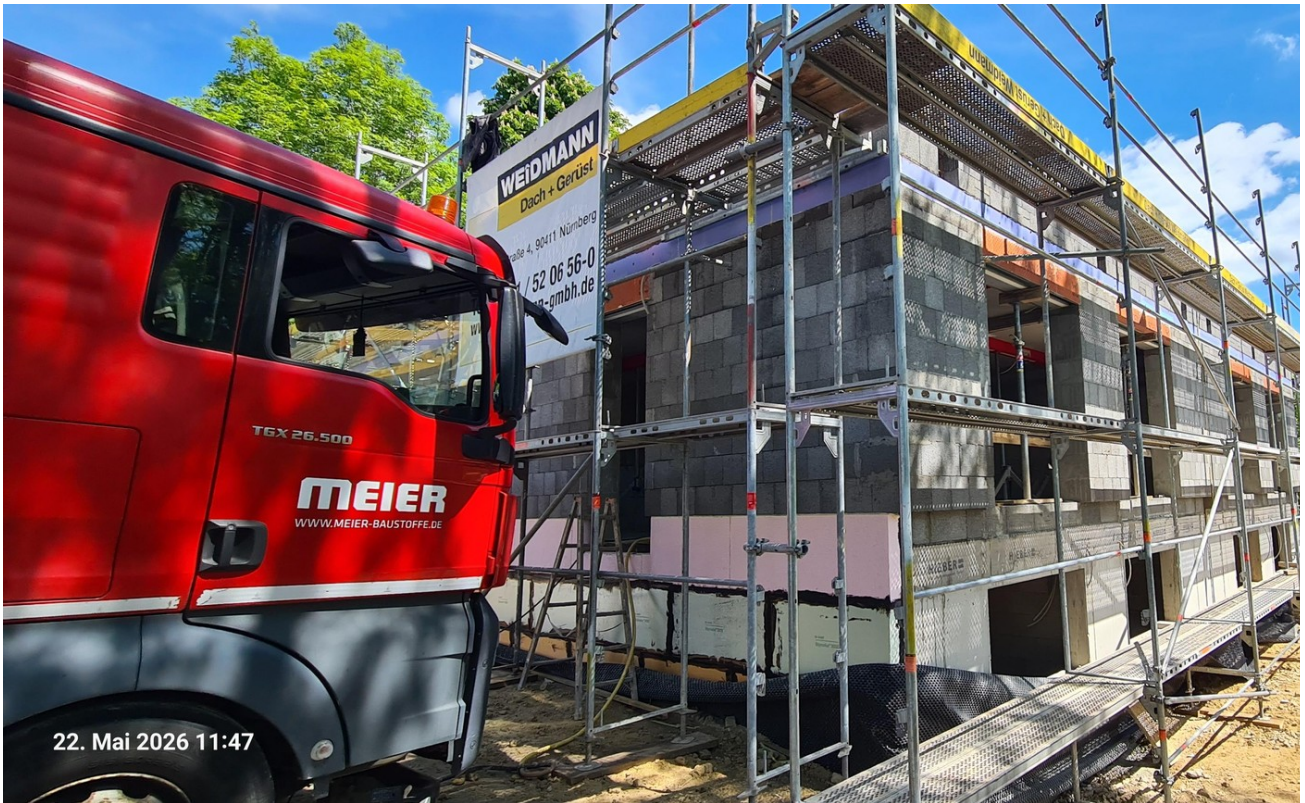
Bautenstand Süd-West Ansicht
