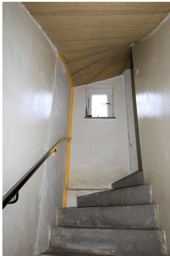
Treppenhaus zum Kellergeschoss
