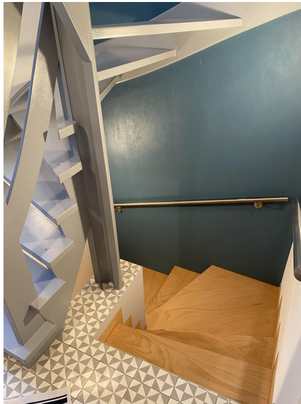
Treppenhaus, Treppe nach unten
