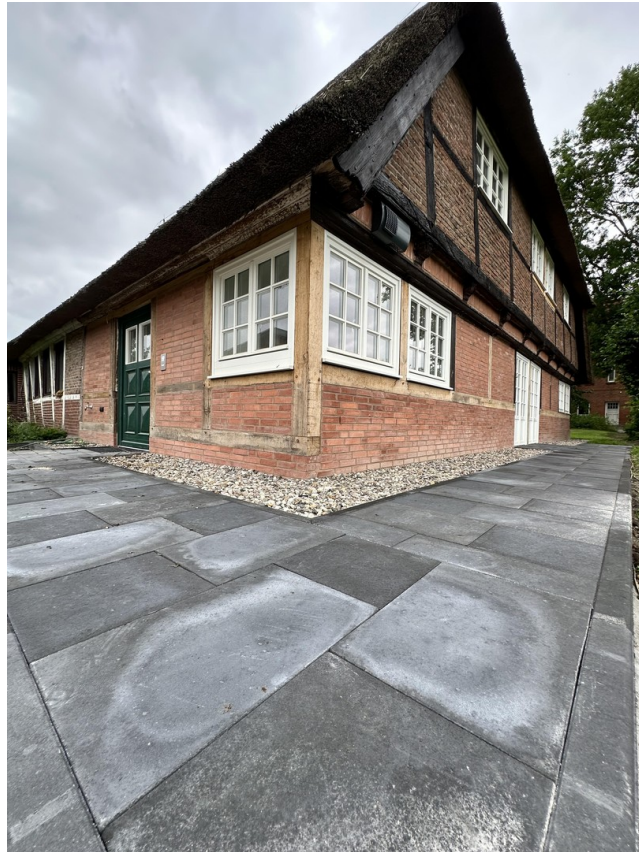
Blick von Nordost
