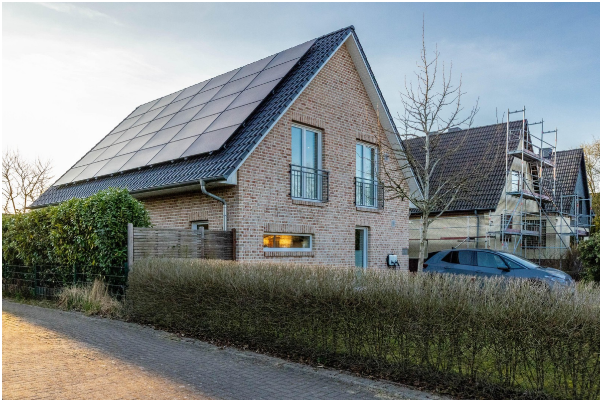
PV Anlage perfekt ausgerichtet
