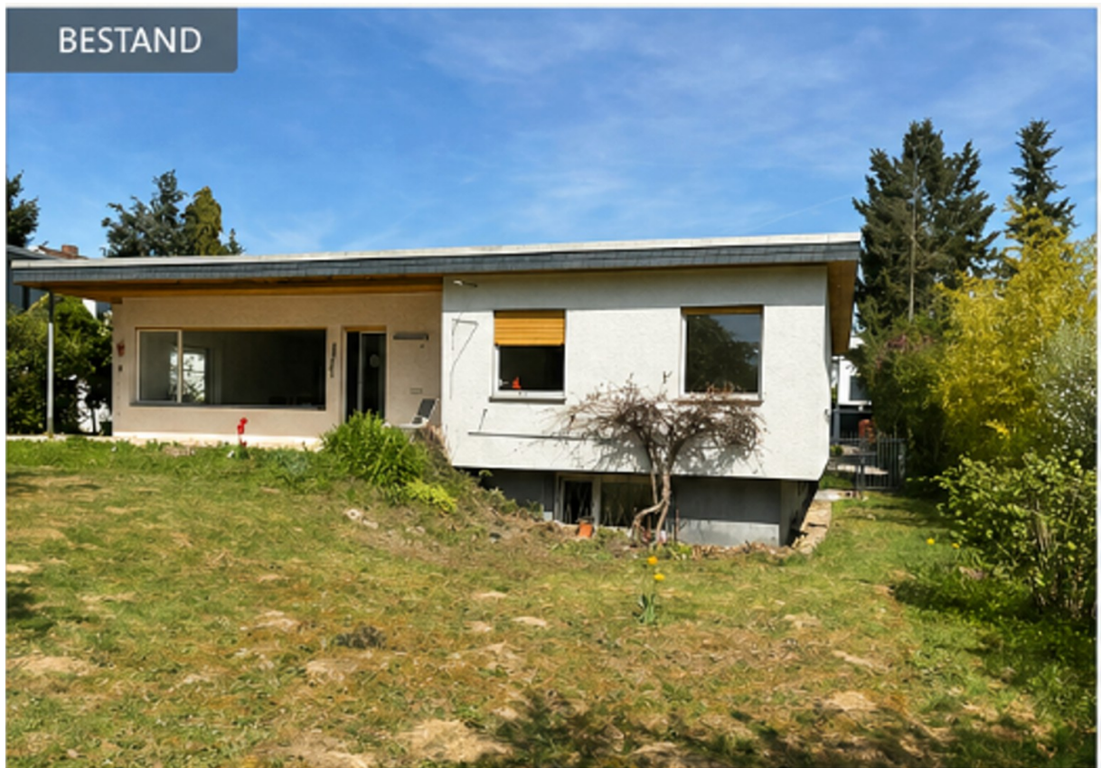
Blick aus Südostecke
