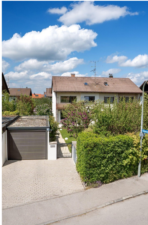
Zugang zum Haus mit Garage
