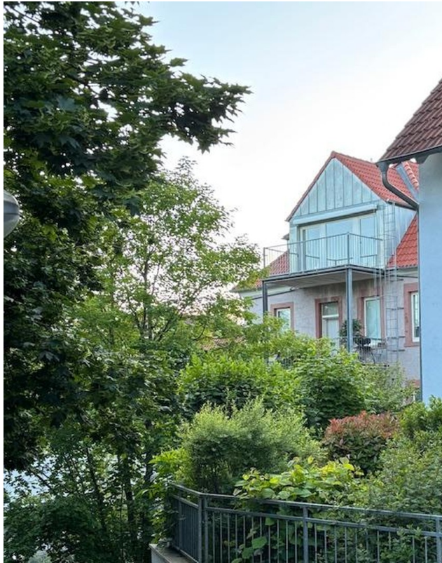
Balkon Ansicht Brennofengasse
