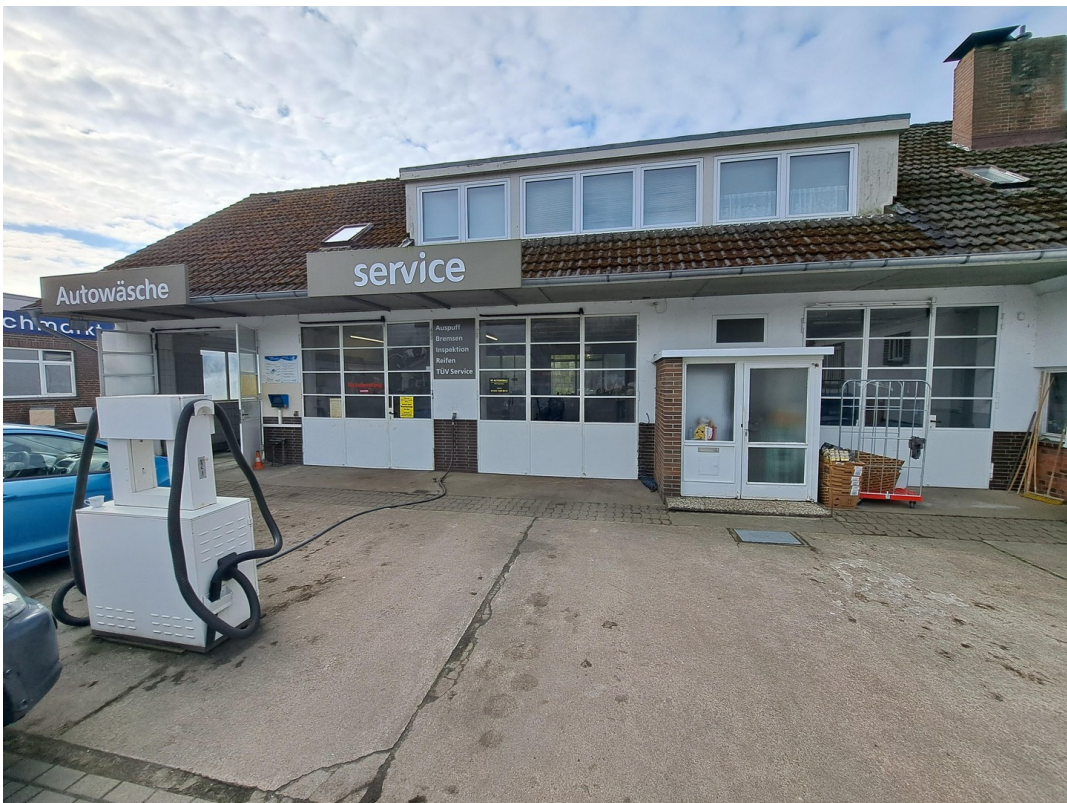
Werkstatt aussen, Eingang Haus
